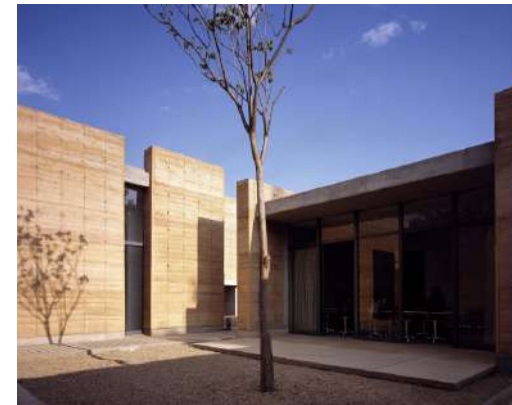
Imagen 77.- Fotografía tomada de la web (www.archdaily.mx,
