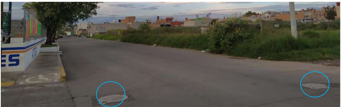
Imagen 37. Salidas de agua en la calle Art. 123
