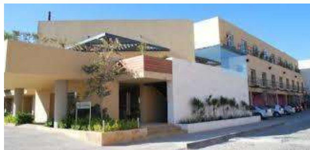
Imagen 16. Perspectiva principal del edificio.
