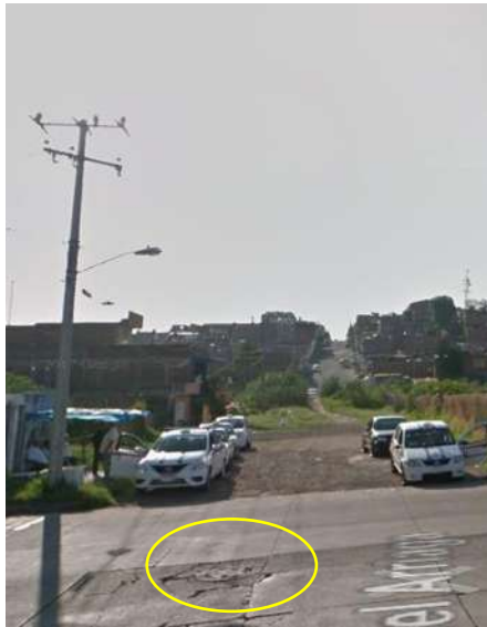
Imagen 40. Salida de drenaje.
