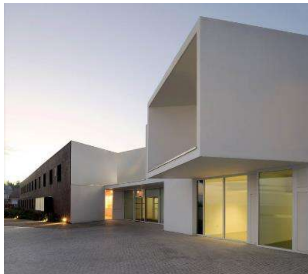
Imagen 14. Perspectiva principal del edificio.
