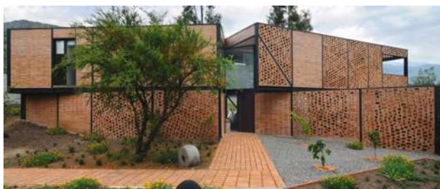
Imagen 13. Fachada Principal Casa 4M.
