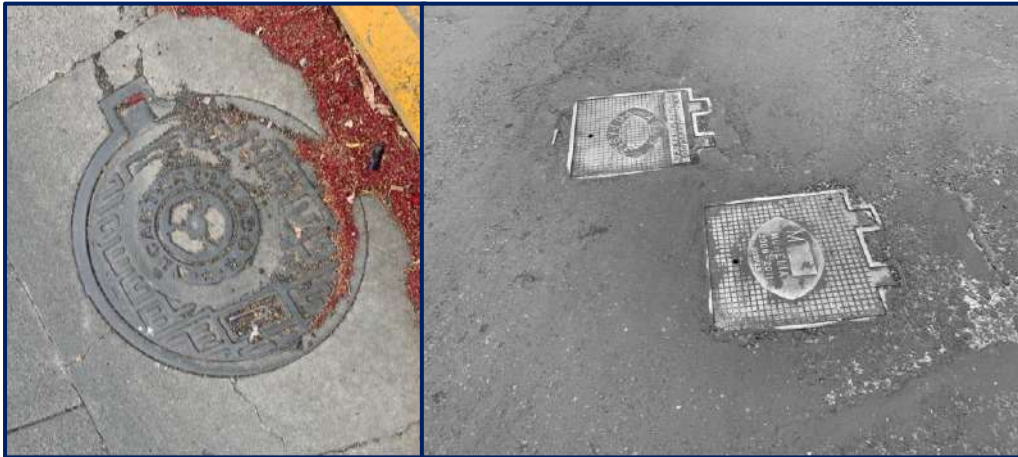
Img. 16: Drenaje y Agua Potable en el sitio. 2020. Fuente de Autor
