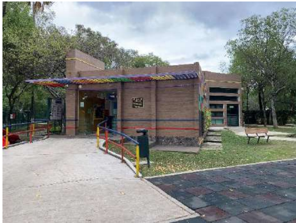
Img. 20: Exterior de la Ludoteca DIF. 2019. Fuente de Autor.
