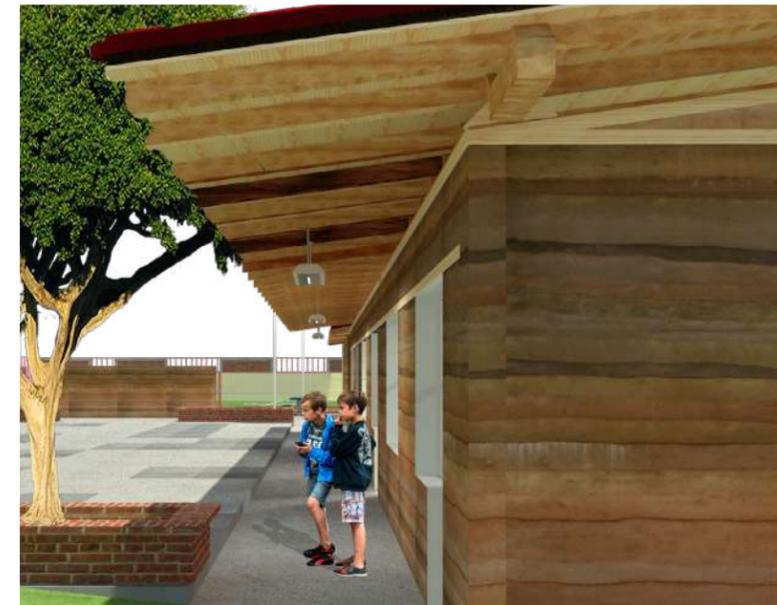
4.3.3. Áreas exteriores. Las circulaciones exteriores se protegerán de la radiación directa o indirecta mediante volados o aleros. En los edificios de un nivel, los volados o aleros serán de por lo menos 1.10 m y con una altura mínima de 2.30 m.
