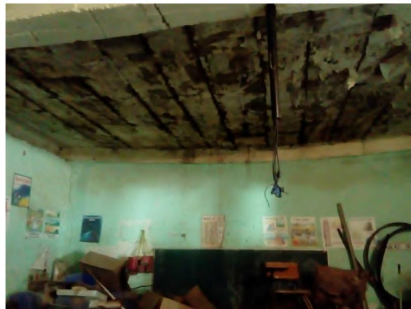
Fotografía 10.- Losa del aula del 4° grado a en alto riesgo de colapso. Fuente: Tomada por el autor (13/09/2019)
