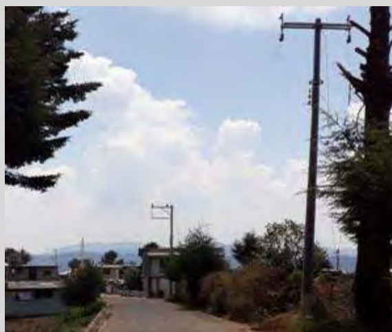
Figura No. 49 Título: Ejecución de los trabajos Descripción: Se verifica la colocación de herrajes y línea en media y baja tensión Créditos: Omar Núñez García
