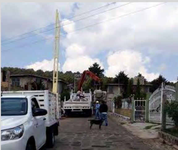
Figura No. 48 Título: Ejecución de los trabajos Descripción: Se verifica la colocación de postes de concreto de 12- 750 Créditos: Omar Núñez García
