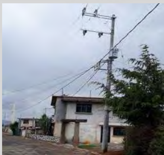
Figura No. 51 Título: Terminación de la Ejecución de los trabajos Descripción: Se verifica la Obra concluida, con postes, herrajes, líneas en media y baja tensión, transformadores y acometidas. Créditos: Omar Núñez García
