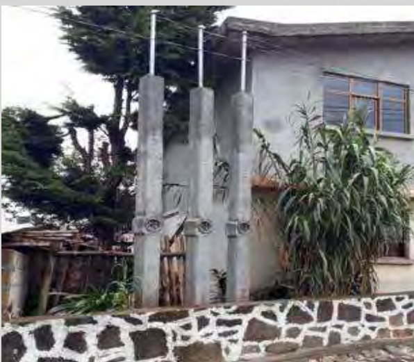
Figura No. 50 Título: Ejecución de los trabajos Descripción: Se verifica la colocación muretes para acometidas o servicios de energía eléctrica nuevos Créditos: Omar Núñez García
