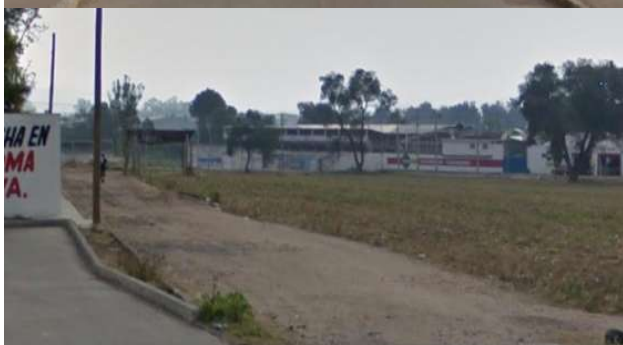
Fig.15.- Estado de Calles Fuente: imágenes propias
