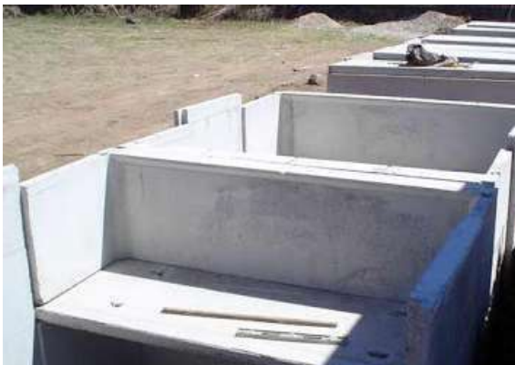
Ilustración 6 Bóvedas prefabricadas de 4 niveles en tierra y cubierta de pasto. http://www.periodicoelsur.com/noticias_guzman.aspx?idnoticia=27135
