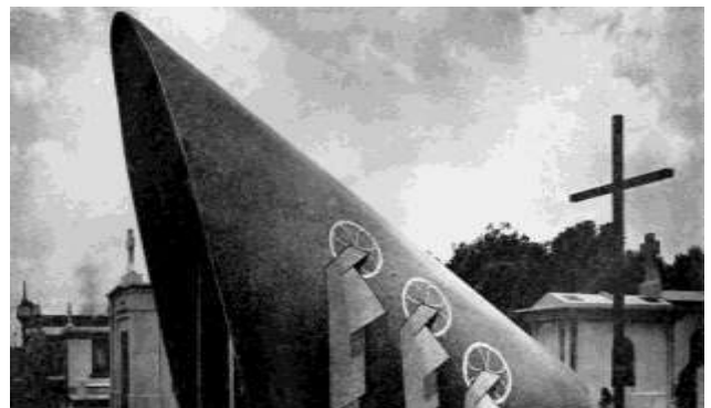
Ilustración 4 Cripta con techo cubierto de mosaico veneciano, Panteón Español, Miguel Hidalgo, Ciudad de México 1957. https://unavidamoderna.tumblr.com/post/170000679402/cr-ipta-con-techo-cubierto-de-mosaico-veneciano
