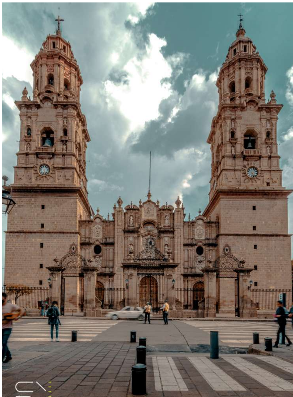
ilustración 34. Angulo Contrapicado. La visión del espectador es menor a la altura del edificio. Fotografía Propia
