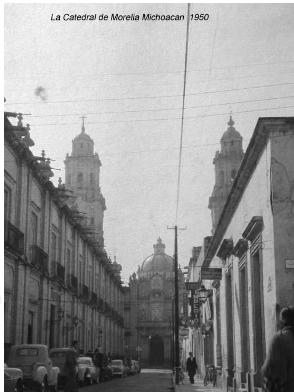
Ilustración 27. Fachada Norte, desde la calle Benito Juárez. Obetenida de México en Fotos.
