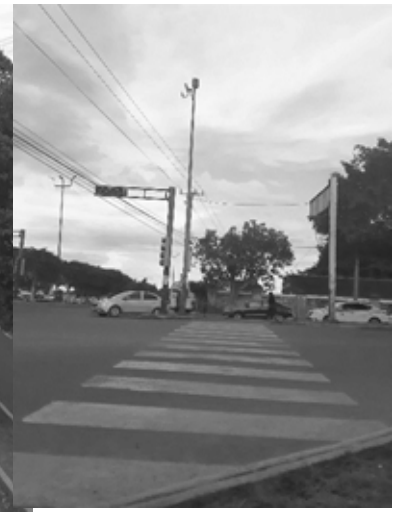
Ilustración 51 falta de rampa para discapacitados o carriolas foto Lizeth Yohana 09-nov-19
