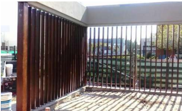
Fig. 9 Edificio con la representación (sistema de parasoles). Elaboración propia.
