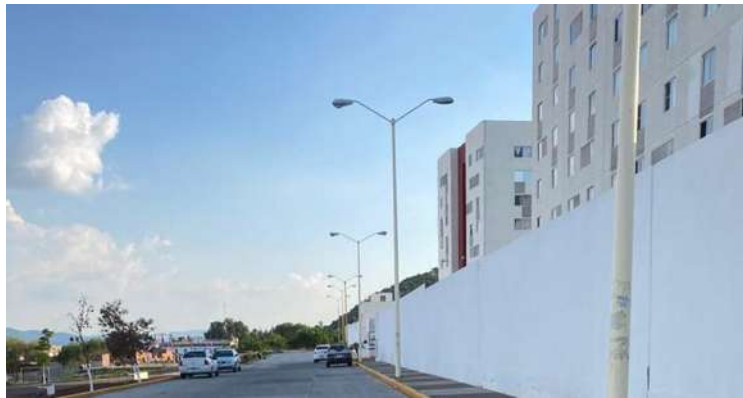
Fig. 18 Entrada principal a edificios. Elaboración propia.
