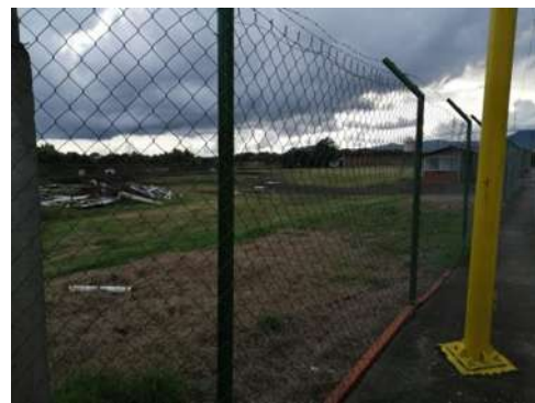
Ilustración 51. Vista del terreno.
