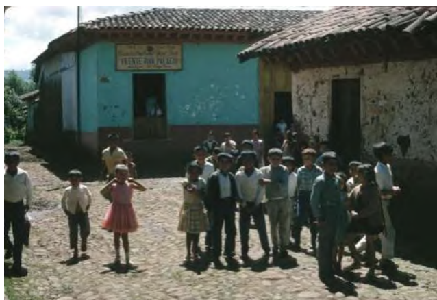
Imagen 71 Vivienda utilizada como edificio educativo. Autor: Raymond E. Wiest. Fecha: 1966
