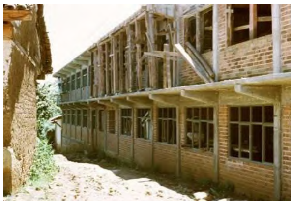
Imagen 72 Edificio en construcción, primaria Riva Palacio. Autor: Raymond E. Wiest. Fecha: 1971
