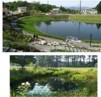
ESTANQUE DE RETENCIÓN Y JARDINES FILTRANTES
