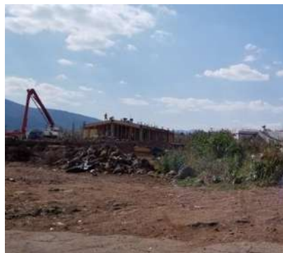
Img. 31 Obra en proceso a un costado del terreno Obtenida por el autor
