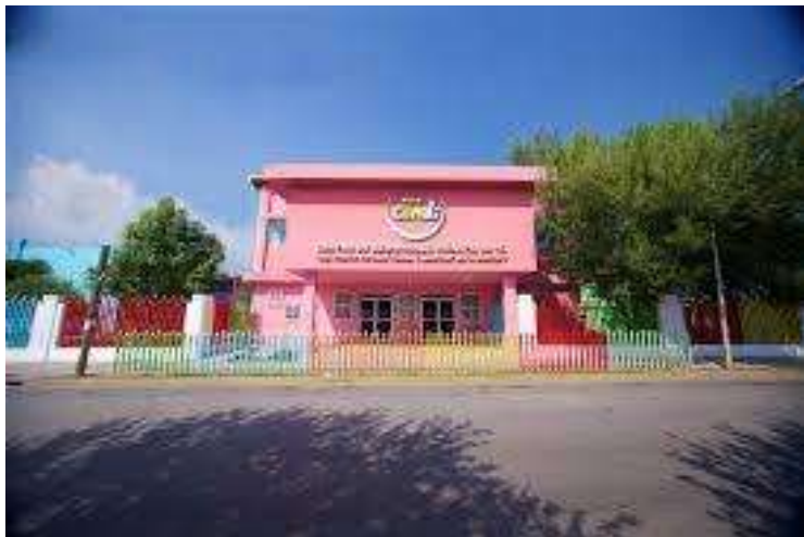
Img. 26 Fachada principal CENDI 13: Lev Vygotsky recuperada de Google imágenes
