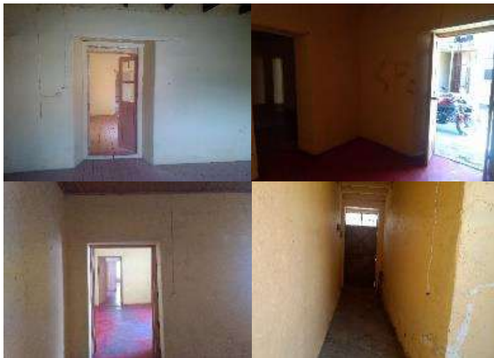
Ilustración 118. Cuatro imágenes internas de la casa Habitacional la cual está basado el proyecto de Acondicionamiento como posada familiar y/o Departamentos. En ellas se observa los muros de adobe, así como las puertas que conducen al patio de servicio, como el ingreso interno de habitación por habitación contigua.
