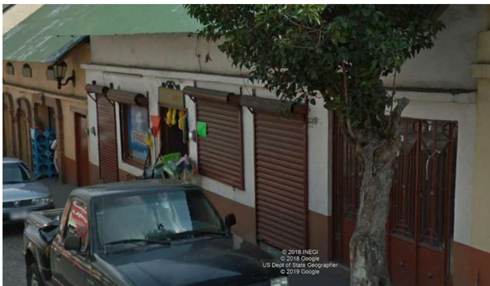
Ilustración 109. Imagen de la Avenida Benito Juárez donde se ubica, el local comercial propiedad de la Dr. Paloma Rodríguez Rodríguez; el cual se desea acondicionar, para un consultorio médico. Para una mejor referencia dicho local comercial, es que aparece cerrado con cortinas de acero de color café.
