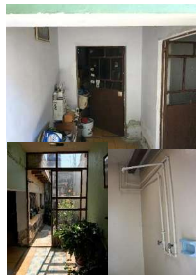
Ilustración 54: Mosaico fotográfico, zona comedor y recamara 3, , fuente: Salomón González Figueroa, [2019-noviembre-10].
