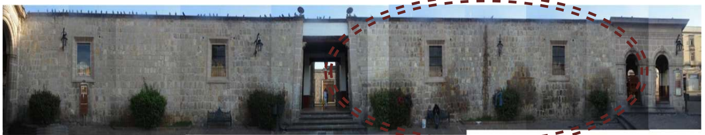
FACHADAS INTERIOR NORTE CALLE CORREGIDORA
