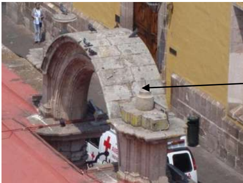
Imagen 25. Vista de los faltantes en elementos arquitectónicos que conforman el inmueble
