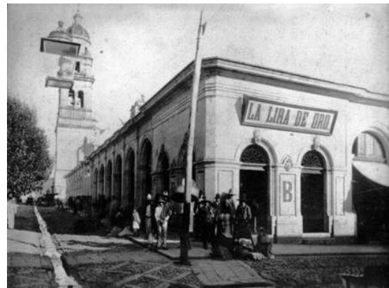
Imagen 4. Foto tomada en contra esquina de la plaza en el siglo XIX.
