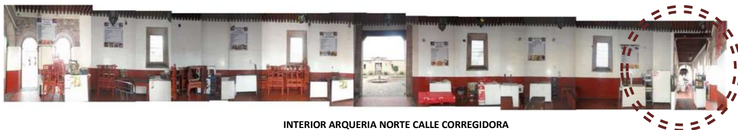
INTERIOR ARQUERIA NORTE CALLE CORREGIDORA
