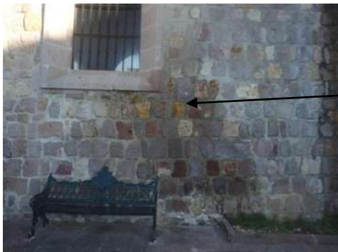
Imagen 15. Vista de la humedad en paramentos interiores Foto: Raymundo Alcalá
