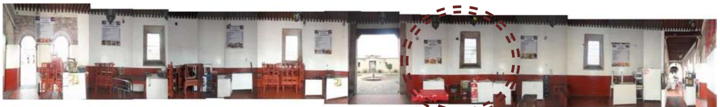
INTERIOR ARQUERIA NORTE CALLE CORREGIDORA
