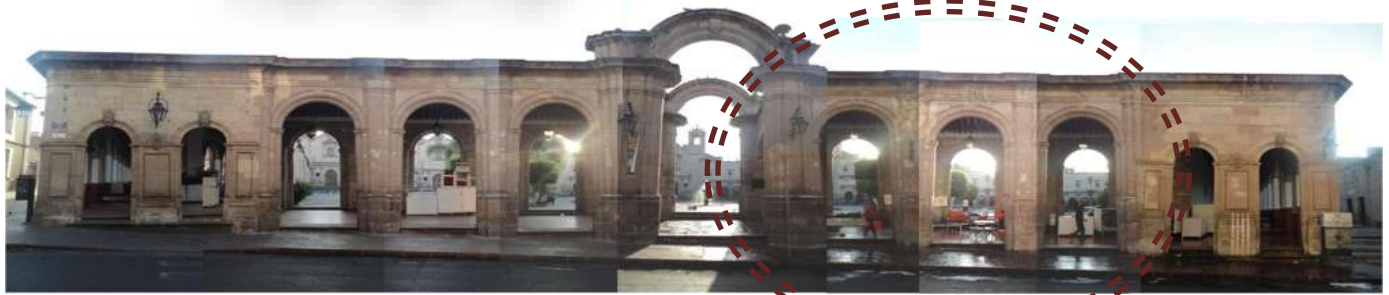
FACHADA PONIENTE CALLE ABASOLO
