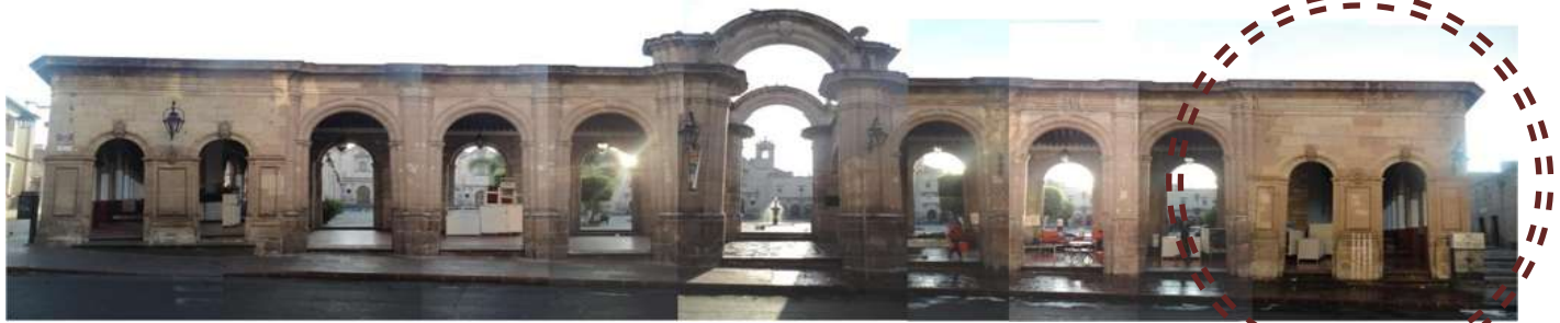
FACHADA PONIENTE CALLE ABASOLO
