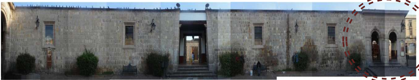
FACHADAS INTERIOR NORTE CALLE CORREGIDORA
