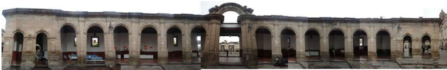
INTERIOR ARQUERIA NORTE CALLE: CORREGIDORA
