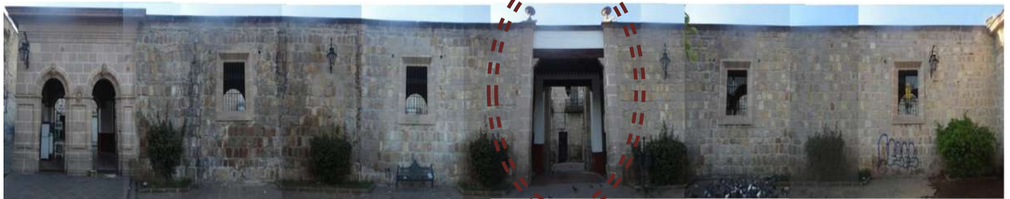
FACHADAS INTERIOR SUR CALLE SAN CRISTOBAL ECATEPEC
