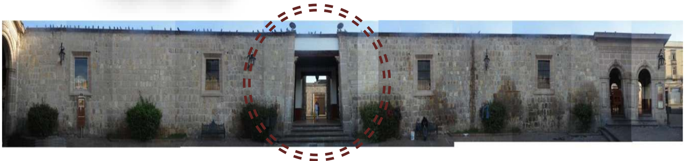
FACHADAS INTERIOR NORTE CALLE CORREGIDORA
