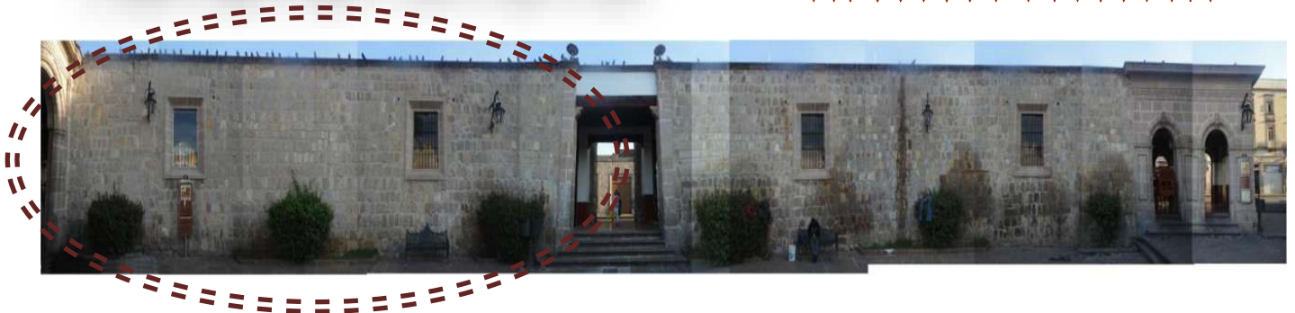
FACHADAS INTERIOR NORTE CALLE CORREGIDORA
