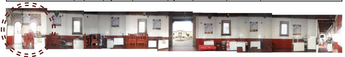
INTERIOR ARQUERIA NORTE CALLE CORREGIDORA
