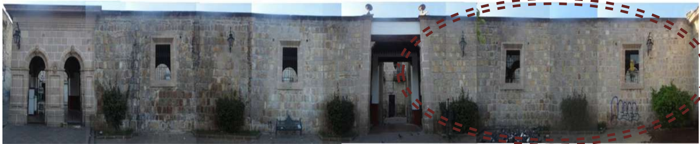
FACHADAS INTERIOR SUR CALLE SAN CRISTOBAL ECATEPEC
