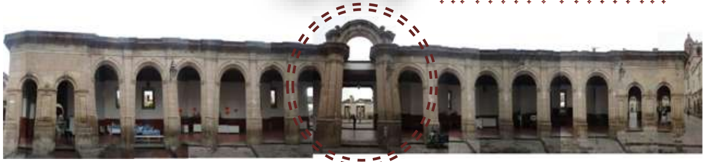
FACHADA SUR CALLE SAN CRISTOBAL ECATEPEC
