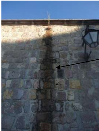
Imagen 23. Vista de las humedades en paramentos en interior de la plaza.
