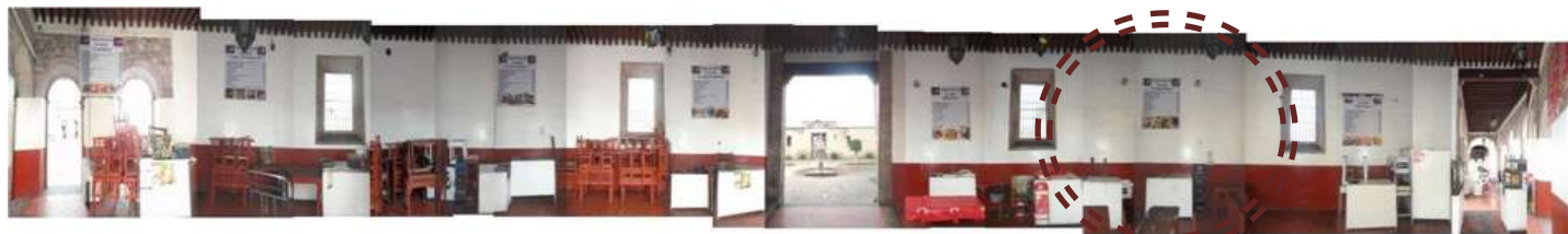
INTERIOR ARQUERIA NORTE CALLE CORREGIDORA
