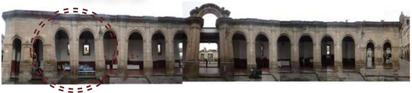
FACHADA SUR CALLE SAN CRISTOBAL ECATEPEC
