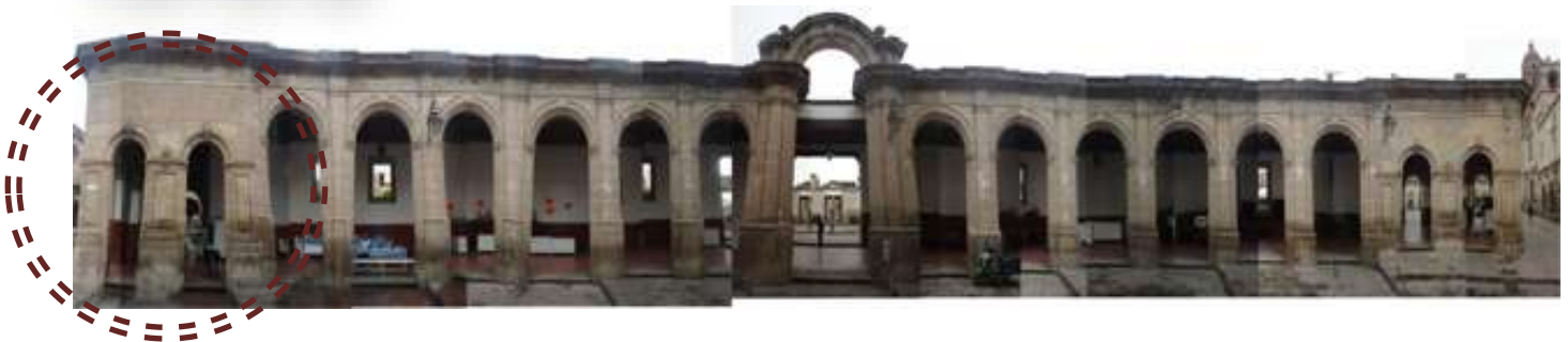
FACHADA SUR CALLE SAN CRISTOBAL ECATEPEC
