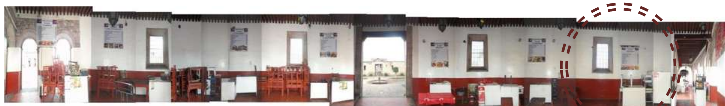
INTERIOR ARQUERIA NORTE CALLE CORREGIDORA
