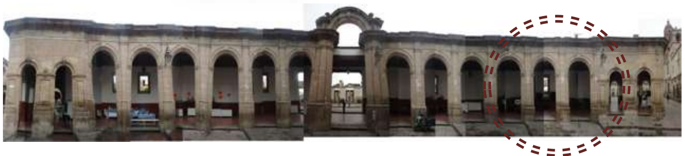
FACHADA SUR CALLE SAN CRISTOBAL ECATEPEC
