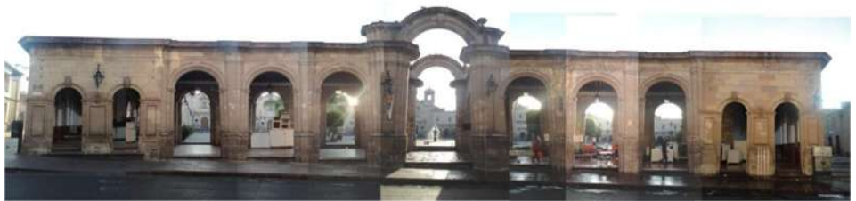
FACHADA CALLE ABASOLO
