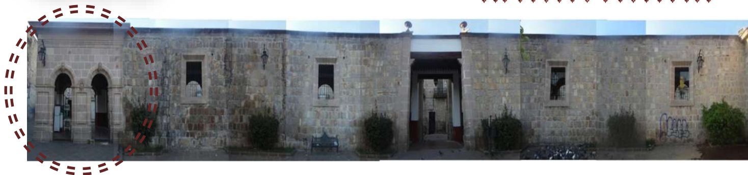
FACHADAS INTERIOR SUR CALLE SAN CRISTOBAL ECATEPEC
