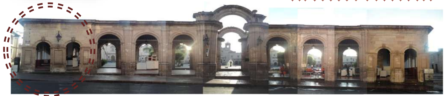
FACHADA PONIENTE CALLE ABASOLO
