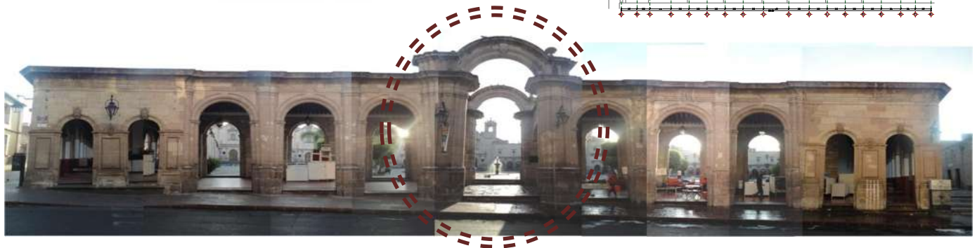
FACHADA PONIENTE CALLE ABASOLO
