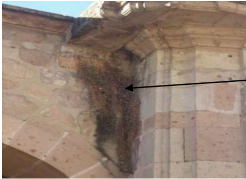
Imagen 17. Vista de la presencia de micro flora en paramentos Foto: Raymundo Alcalá
