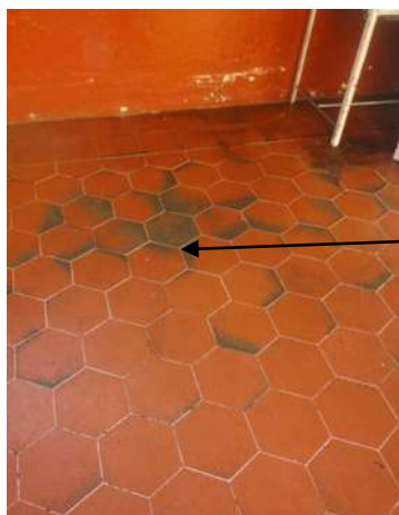
Imagen 28. Vista de las fracturas y decoloraciones en piso de mosaico de pasta encontrado en interior de arquería.
