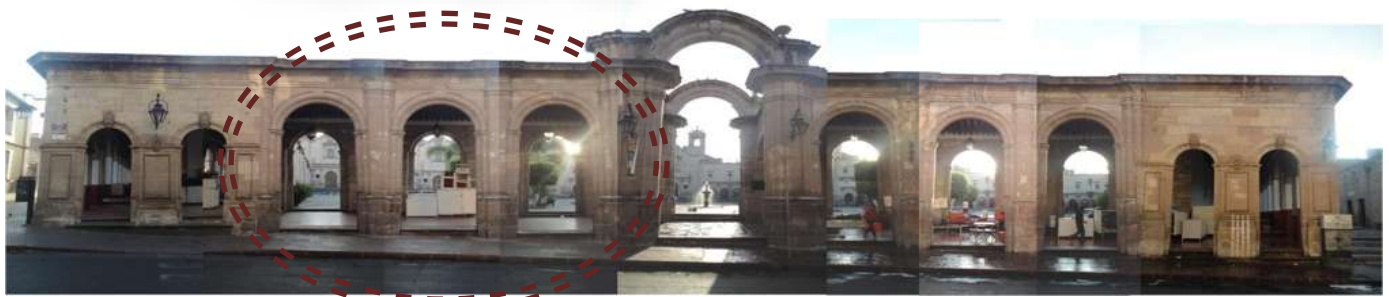
FACHADA PONIENTE CALLE ABASOLO
