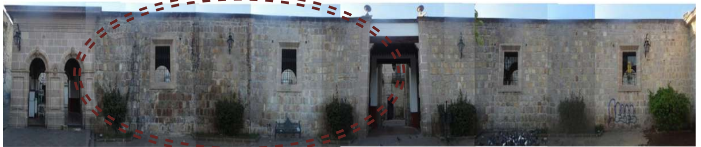
FACHADAS INTERIOR SUR CALLE SAN CRISTOBAL ECATEPEC
