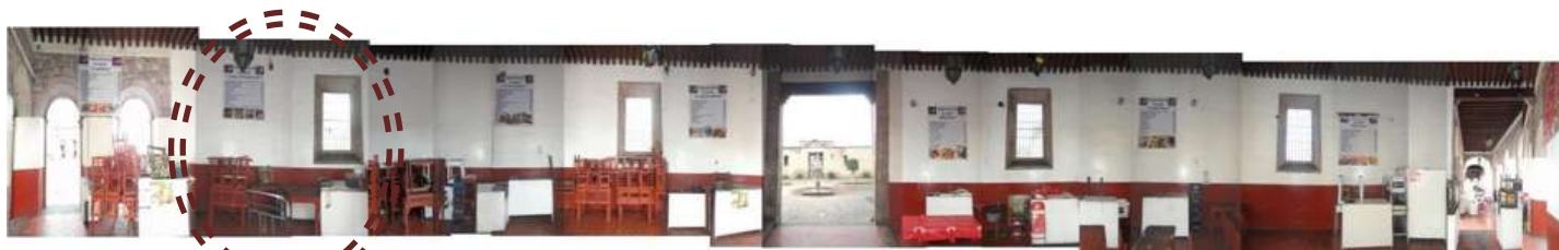
INTERIOR ARQUERIA NORTE CALLE CORREGIDORA
