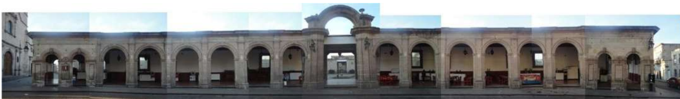
FACHADA EXTERIOR PONIENTE CALLE: ABASOLO
