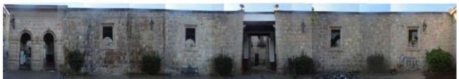
FACHADA INTERIOR CALLE SAN CRISTOBAL ECATEPEC
