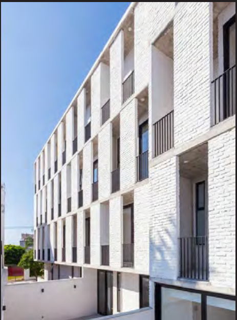
Imagen N° 22 "Condominio Colomos / GONZALEZFRANCO Arquitectura. Vista a la fachada lateral del edificio". Fuente: ArchDaily.
