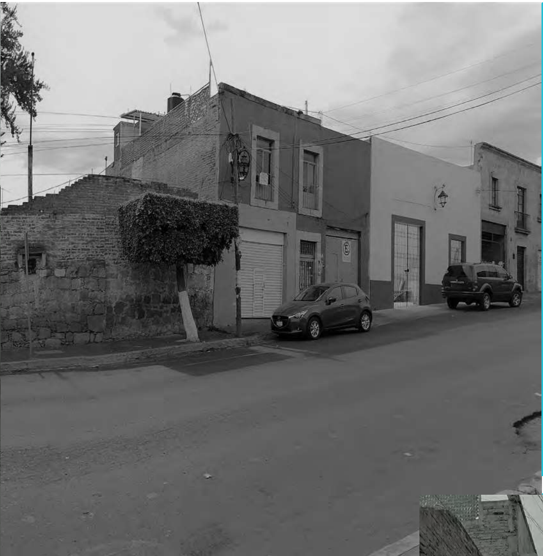
Imagen N° 61. "Fotografía del contexto inmediato con vista Este hacia el predio". Realizada y editada por Dante Y. Zacarías González, 2021.
