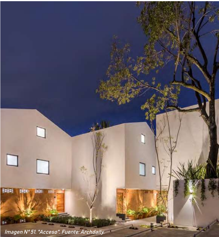
Imagen N° 51. "Acceso". Fuente: Archdaily
