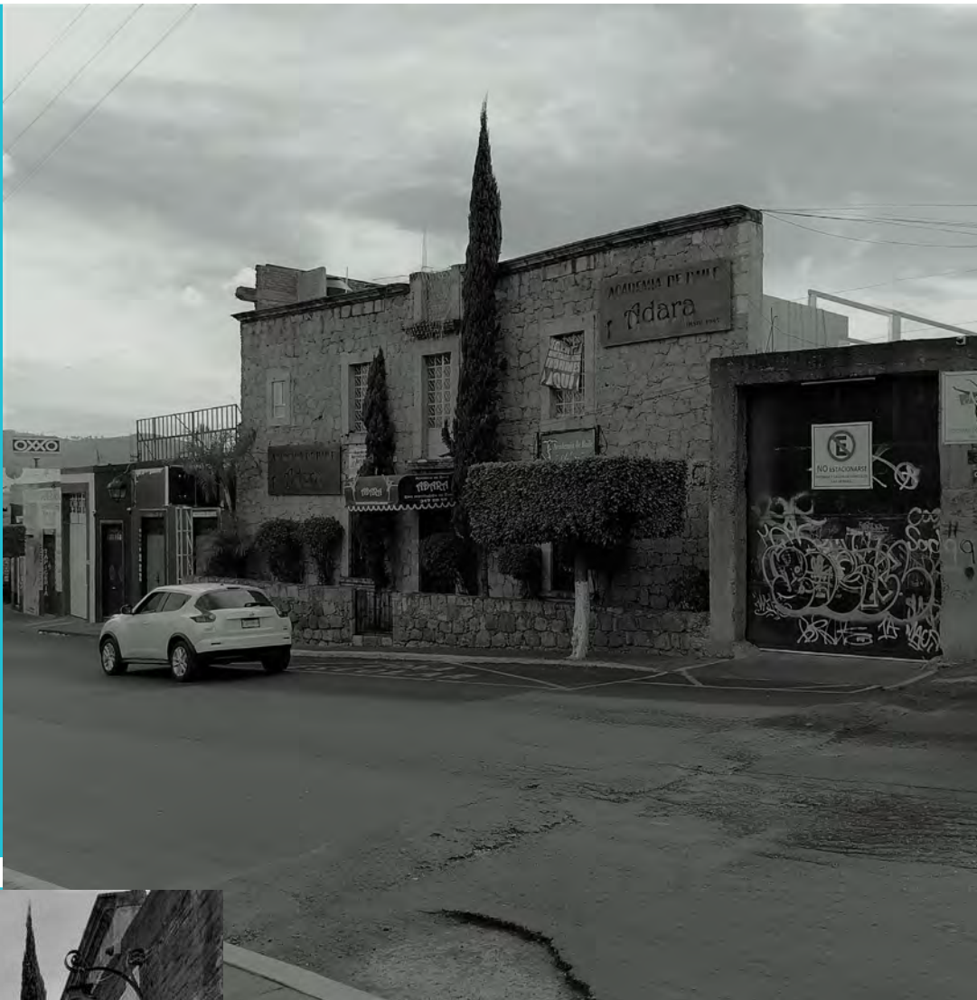
Fotografía con vista Oeste hacia el predio.
