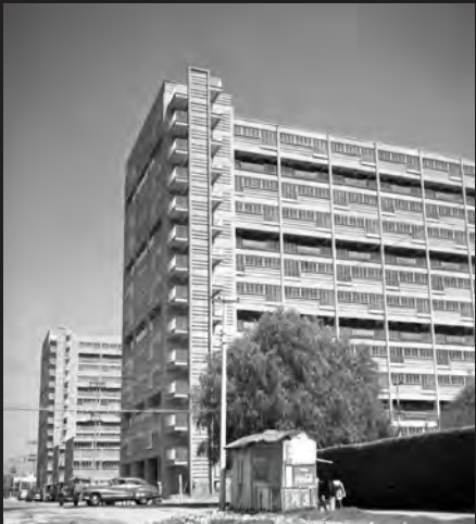
Imagen N° 15 "Edificio CUPA" Colección Fundación ICA. Fuente: ArchDaily.
