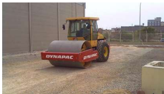
Fig. 64 Compactación del terreno
