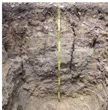
Fig. 56 Excavación a cielo abierto material Vertisol
