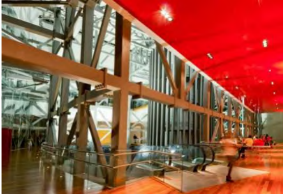
Ilustración 23. Armadura tipo Warren del Museo del mundo Maya recuperado de ArchDaily.
