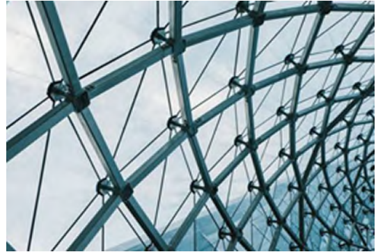
Ilustración 67. Esqueleto de la estructura de acero.
