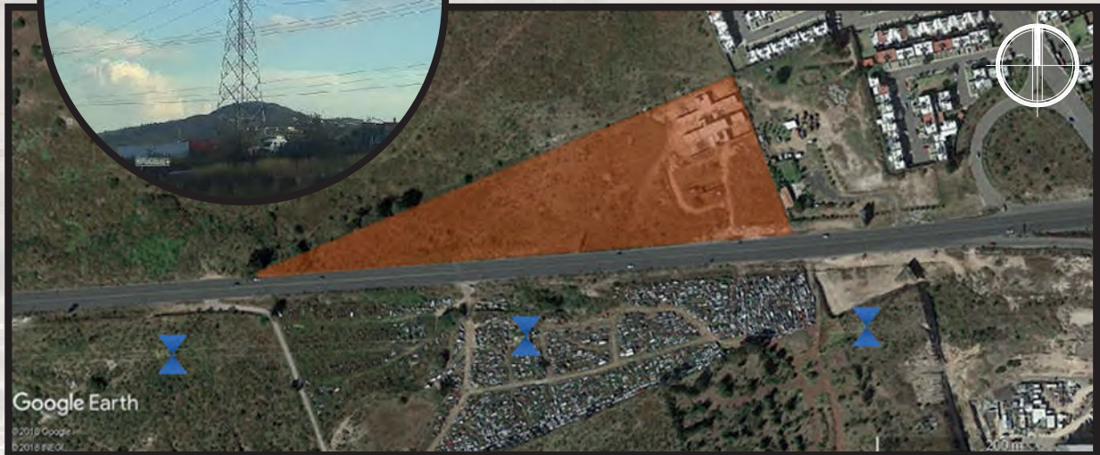
Imagen 52. Infraestructura de torres de Alta tensión
