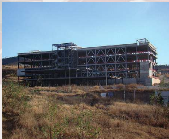
Imagen 4. Nuevo Hospital Infantil en construcción
