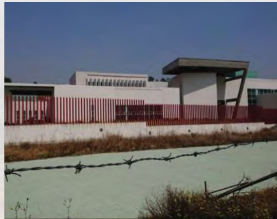
Imagen 1. Hospital abandonado en Estado de México
