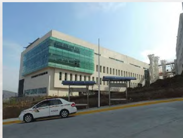
Imagen 5. Nuevo Hospital Infantil en etapas finales de construcción
