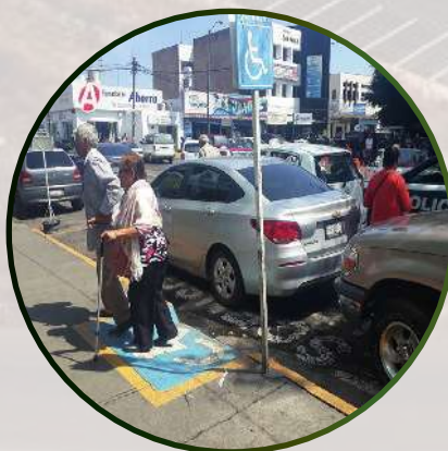
Imagen 18. Obstrucción de rampas en calle Isidro Huarte
