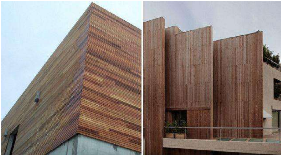
FIG 62. Madera en fachada
