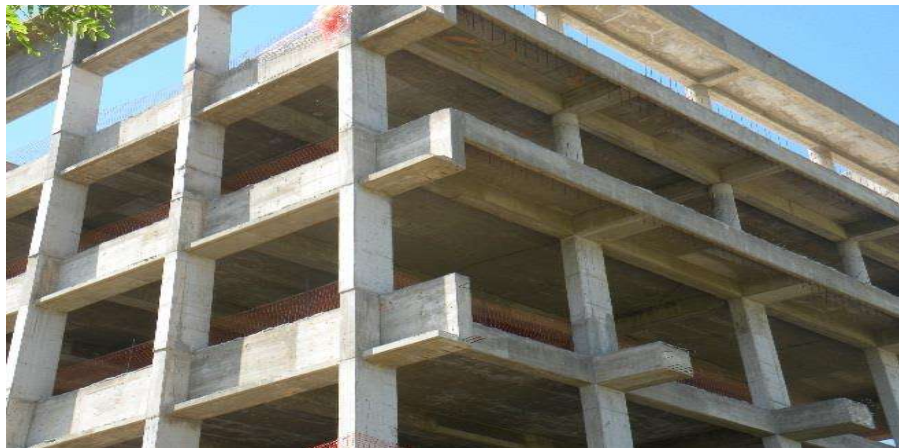
FIG 58. Estructura de concreto
