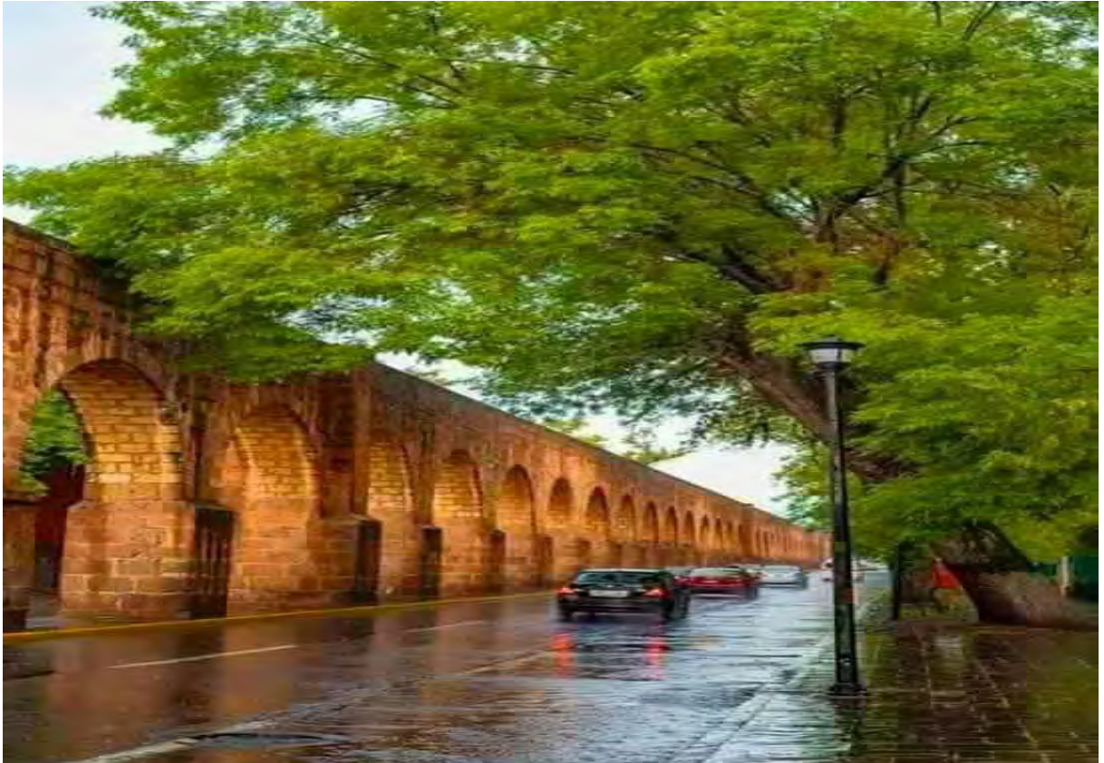
Ilustración 35 Av. Acueducto, Tomada en sitio
