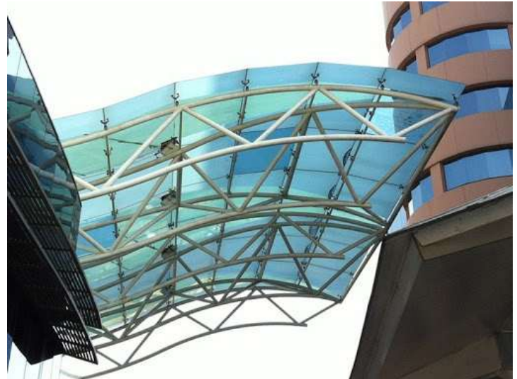
Figura 73. Tridilosa soportando cubierta de vidrio. Fuente página de internet Industrias Technyglaz http://www.technydom.com.mx/Galer%C3%A1-Da-de-Productos/galleryType/SlideShow/ItemID/261.aspx consultada el 3 de enero del 2021.
