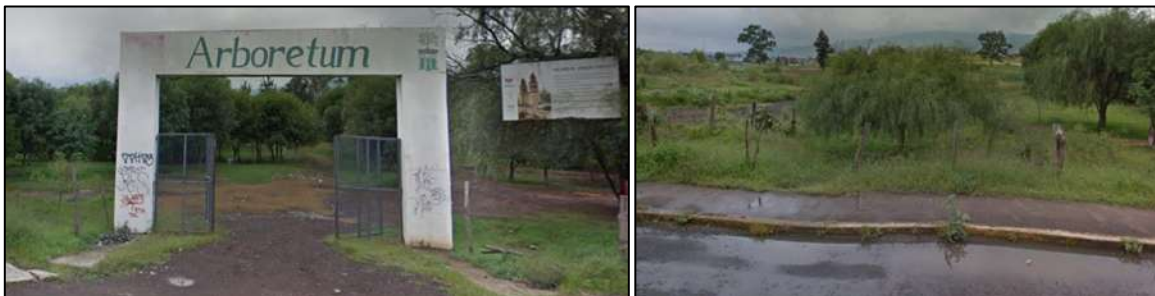
Ilustración 1. Acceso al predio, observando el descuido e infraestructura deficiente. Fuente: Mapa Digital de México INEGI
