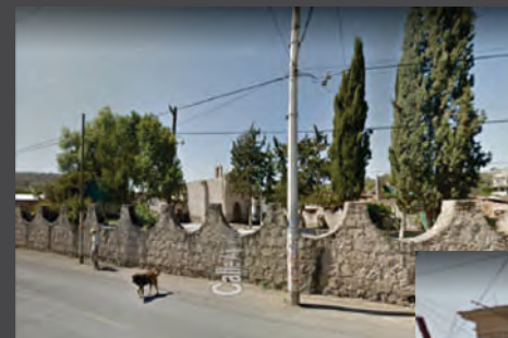
Imagen 62. Muro perimetral de la capilla del barrio de Santiago. FUENTE: Yeraldin Maciel Benegas [06/11/2020]
