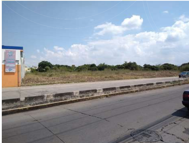
Ilustración 37. Canal de aguas pluviales. tomada: Alexis Uriel Estrada Salas.
