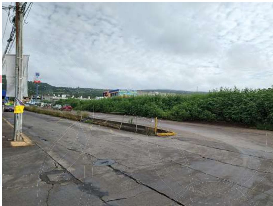
Ilustración 14. Canal de agua pluvial cercano al terreno.
