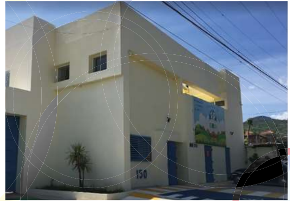
Ilustración 1. FACHADA, GUARDERIA IDEIM.
