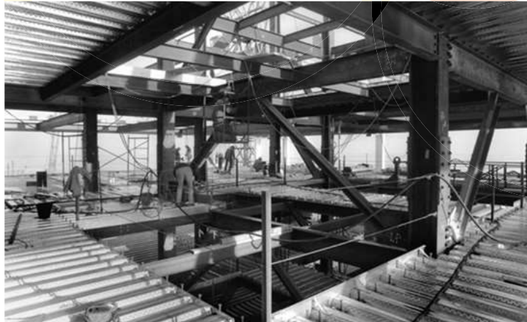
Ilustración 114. Utilización de estructuras mixtas.
