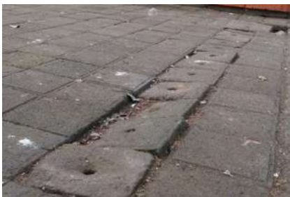
Fotografía 100. Fotografía propia, 2020, drenaje al interior de la plaza, Nahuatzen
