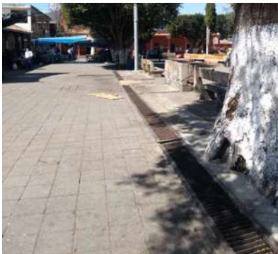
Fotografía 101 fotografía propia, 2020, rejillas para drenaje, Nahuatzen
