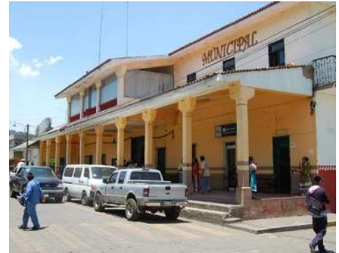
Fotografía 53. Nahuatzen, 2011, Presidencia municipal, Nahuatzen, recuperado de https://nahuatzen.wordpress.com/2011/06/13/presidencia-municipal-nahuatzen/
