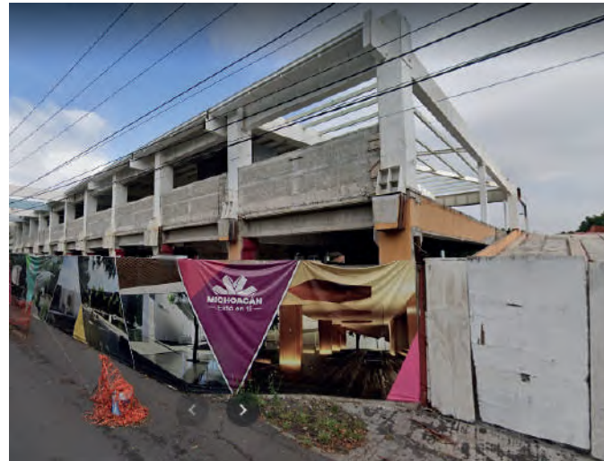
Ilustración 75. Centro de convenciones. Tomada por autor.
