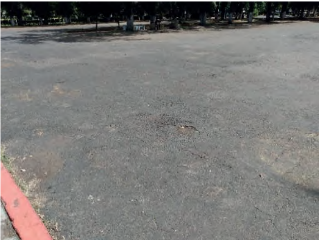
Ilustración 59. Pavimentos. Tomada por autor.
