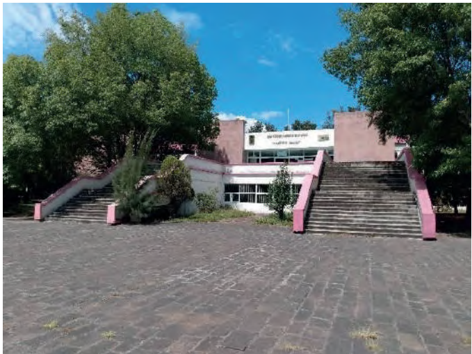
Ilustración 70. Biblioteca pública. Tomada por autor.
