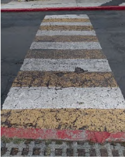
Ilustración 61. Pavimentos. Tomada por autor.
