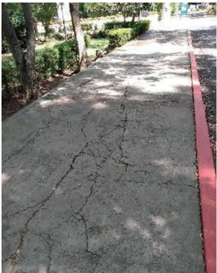
Ilustración 58. Pavimentos. Tomada por autor.
