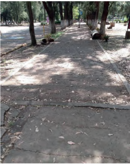
Ilustración 60. Pavimentos. Tomada por autor.
