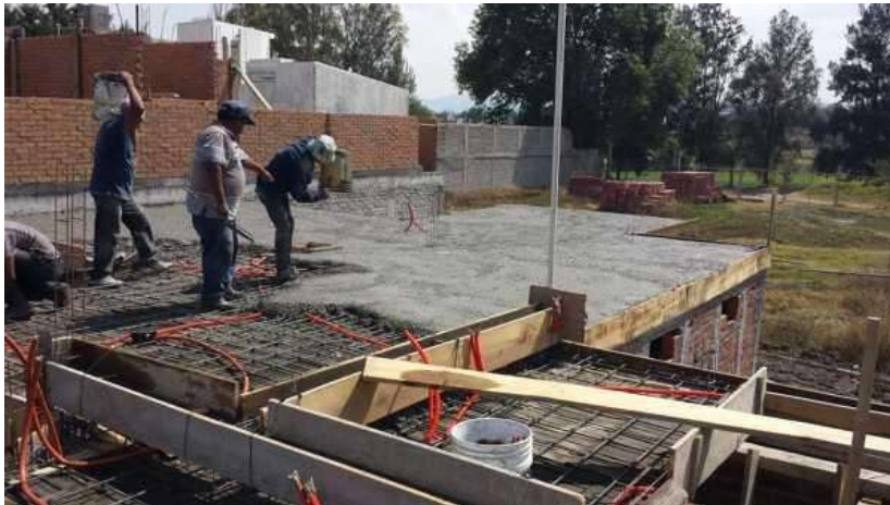
Fig. 5.3. Colado de losa maciza, donde se aprecia el armado y la preparación para instalación eléctrica ahogada en losa. Fuente: Foto: Colado de Losa Maciza de Bejattos SA de CV #450890 - Habitissimo [23-06-21]
