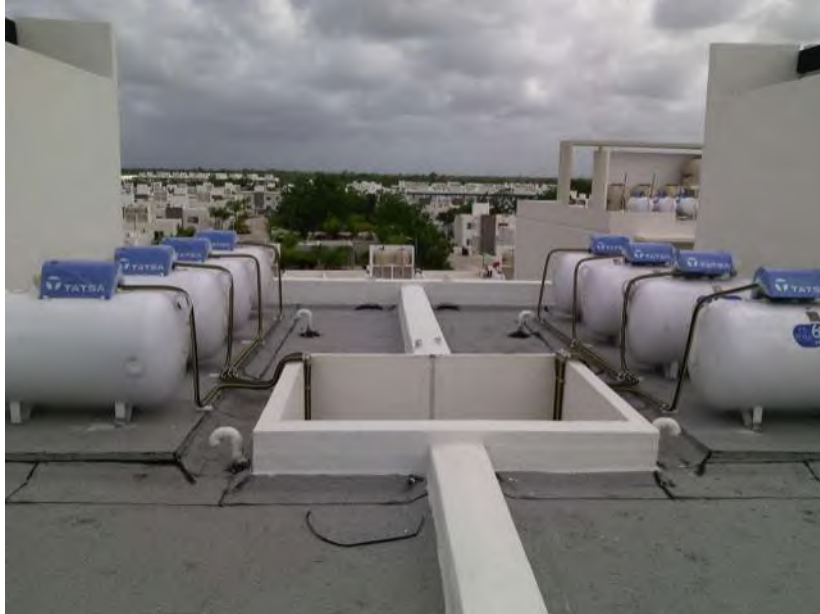
Fig. 5.7. Tanques estacionarios en edificio de departamentos. Fuente: https://www.grupo-maxigas.com.mx/ [23-06-21]
