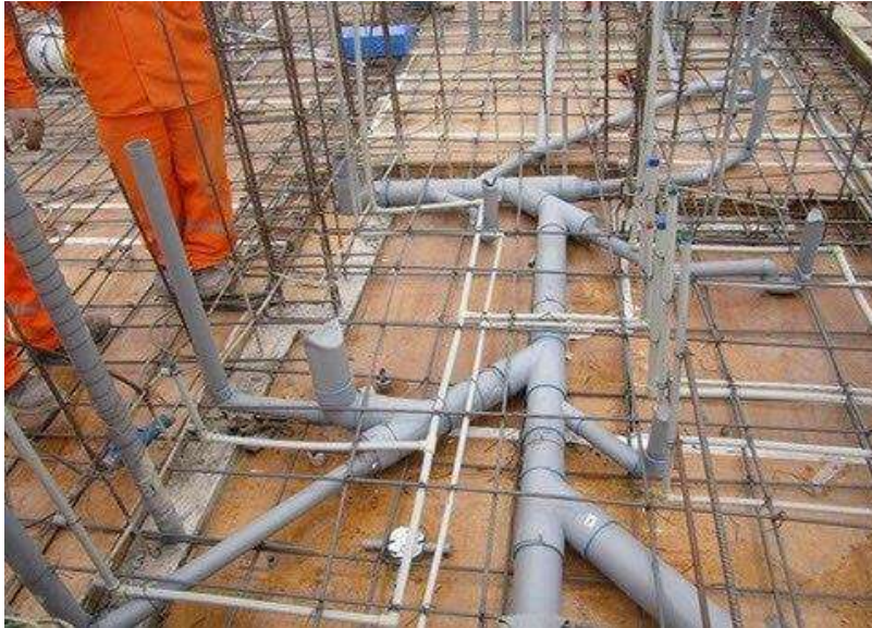
Fig. 5.5. Conexiones de instalación sanitaria, que irán ahogadas en firme.
