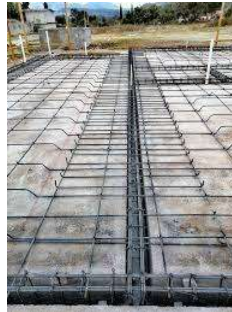
Fig. 5.1. Fotografía de losa de cimentación de concreto armado, donde se observa el armado de la losa y las trabes que integran el sistema. Fuente: Martín Gómez Arquitectura
