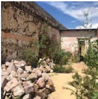
Fig. 0.9. Crecimiento de hiervas y deterioro de los muros perimetrales. Fotografía: Cp. RGP
