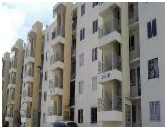
imagen 23 torre de departamentos de cuatro pisos
