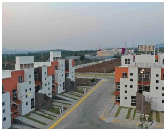
imagen 20 Casas dúplex de dos pisos
