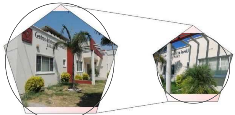
Figura 116. Sistema constructivo a base de concreto y pintura en fachada principal del Centro de Integración Juvenil de Salamanca, Guanajuato. Fuente: Elaboración propia en Corel DRAW X8.
