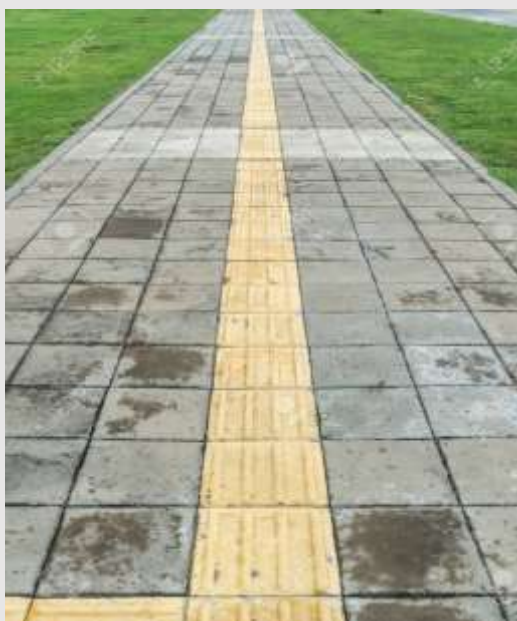
Figura 12, Losetas Táctiles , Edición Electrónica 2021, Extraída de: [ https://es.123rf.com/photo_64811712_pavimentos-t%C3%A1ctiles-para-ciegos-h%C3%A1ndicap.html ] FECHA DE CONSULTA: agosto 11, 2021]
