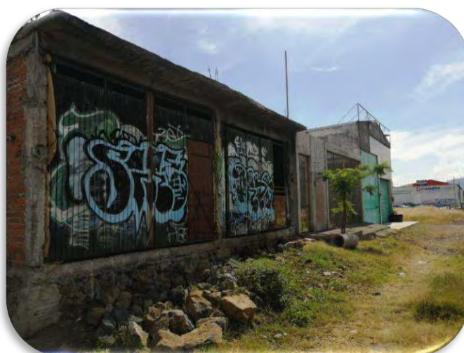
Imagen 3 12 Vista al oriente del predio (Habitacional), ubicado en Periférico paseo de la Republica Col. la quemada, Morelia Michoacán, Fuente propia
