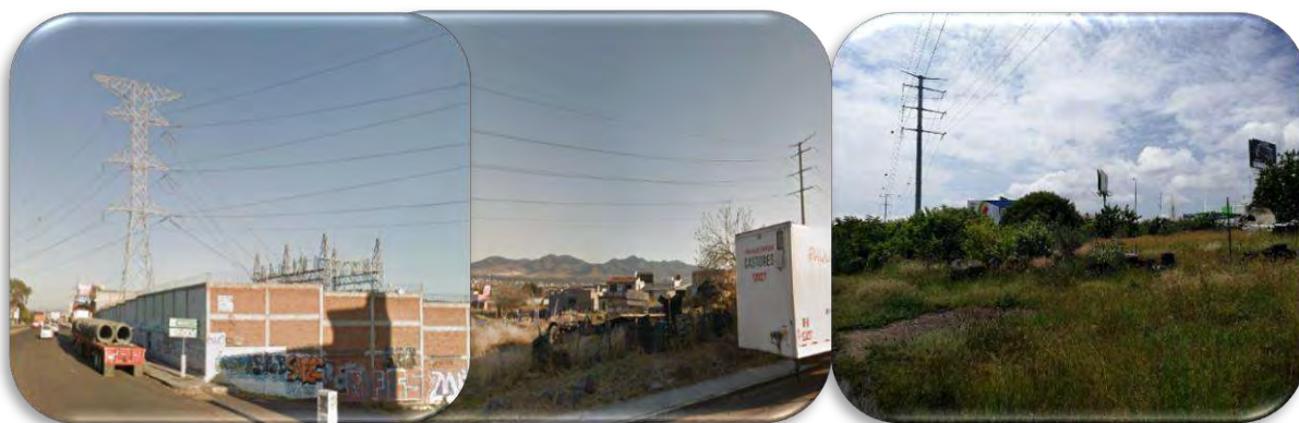
Imagen 3 22 Red de repartición eléctrica, Fuente propia, [18-10-2020]
