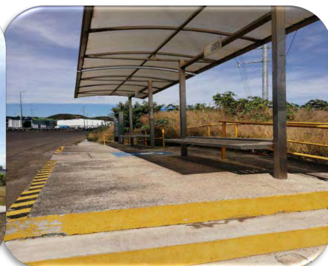
Imagen 3 11 Vista sur del predio (Para de autobuses), ubicado en Periférico paseo de la Republica Col. la quemada, Morelia Michoacán, Fuente propia
