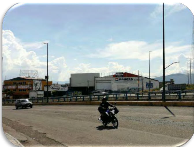
Imagen 3 8 Vista Poniente del predio ubicado en Periférico paseo de la Republica Col. la quemada, Morelia Michoacán, Fuente propia
