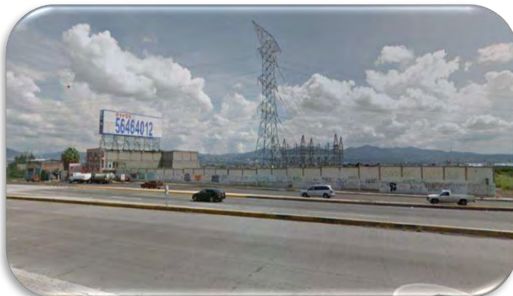
Imagen 3 5 Vista Norte del predio (subestación Morelos), ubicado en Periférico paseo de la Republica Col. la quemada, Morelia Michoacán, Fuente propia
