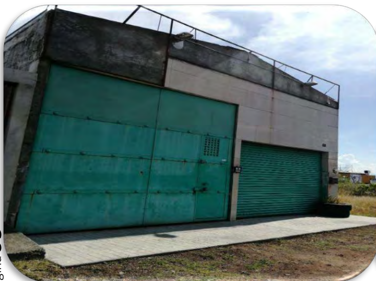
Imagen 3 10 Vista Sur del predio (Habitacional), ubicado en Periférico paseo de la Republica Col. la quemada, Morelia Michoacán, Fuente propia
