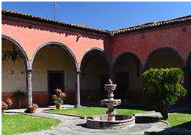
Ilustración 81. Patio central Casa colonial Ecuandureo. Fuente: Fotografía propia.
