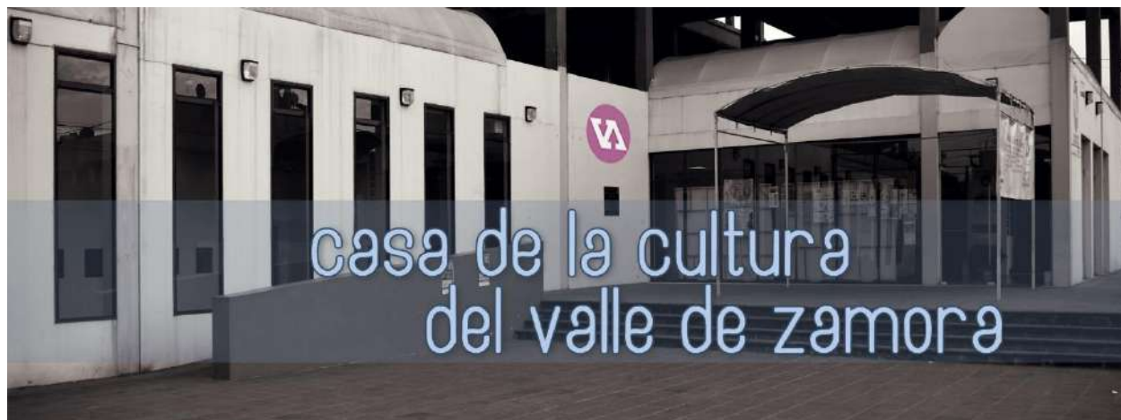
Ilustración 8. Acceso Principal al Instituto, de carácter privado. Fuente: http://www.casacultura.com.mx/historia
