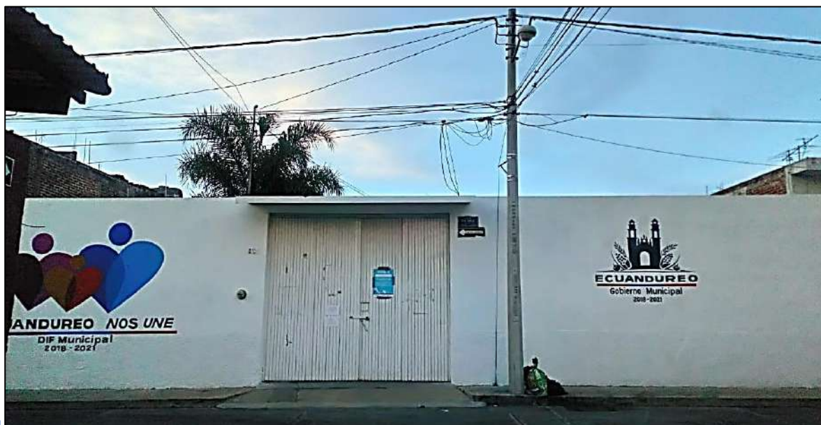
Ilustración 32. Fachada Principal de la Casa de la Cultura orientada hacia el sur. Fuente: Fotografía propia.
