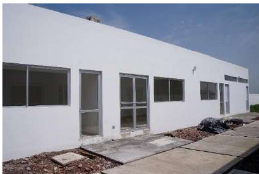
Ilustración 34. Acceso a Biblioteca. Fuente: Fotografía propia.
