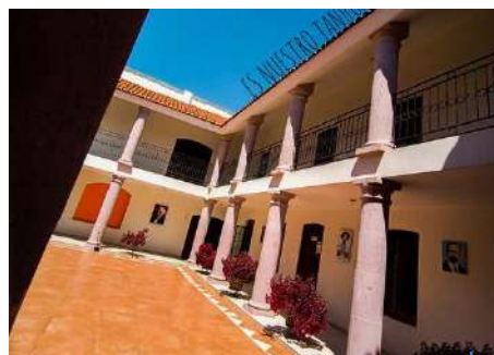
Ilustración 3. Interior Casa de la Cultura. Fuente: (Living Tanhuato, s.f.)
