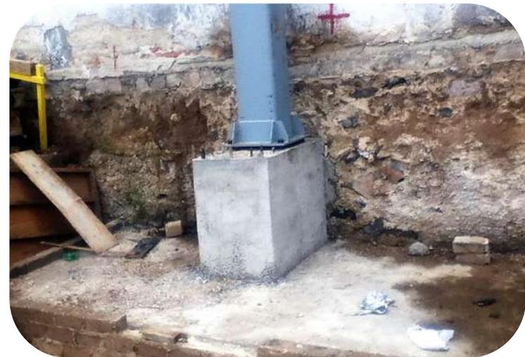
**Figura 24:** *zapatas aisladas de concreto.*
