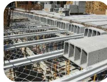
**Figura 32:** losa de vigueta y bovedilla.
