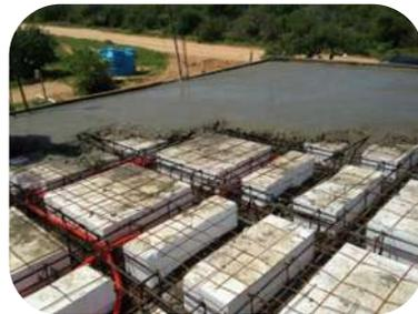
**Figura 31:** losa aligerada con casetón.
