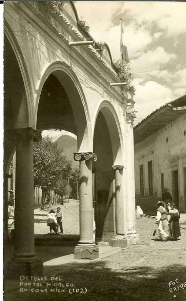
Fotografía 4 Detalle de portal antes. Fuente: Archivo histórico Quiroga. En la fotografía se aprecia el Sistema constructivo del piso a base de piedra quebrada.
