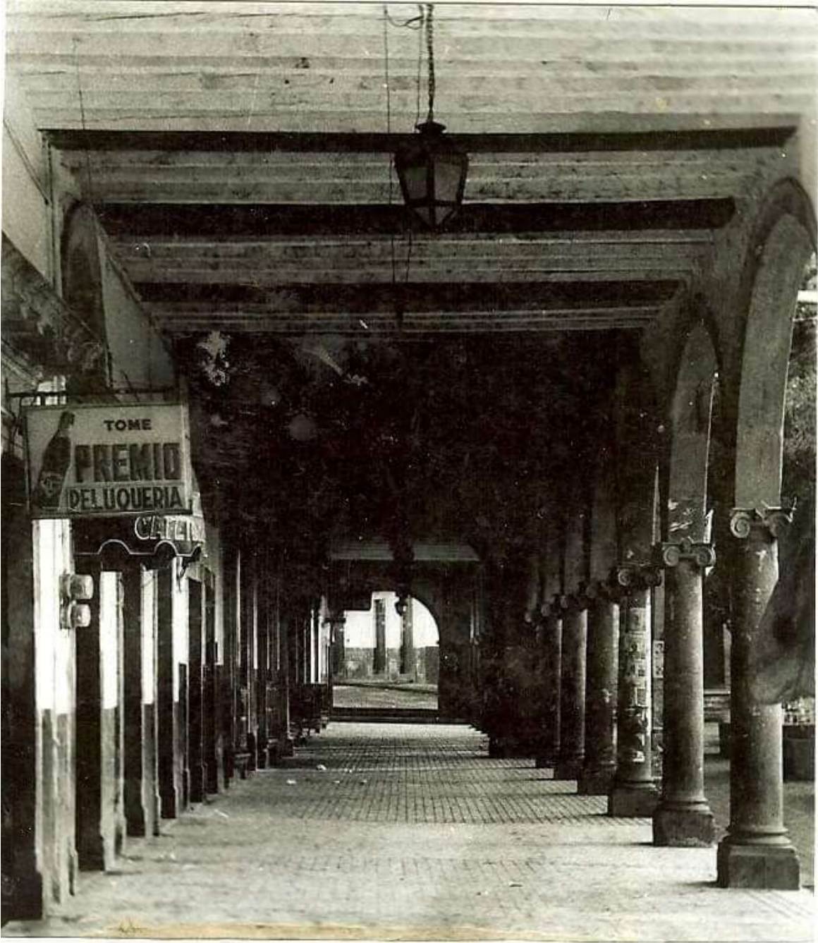
Fotografía 11 vista portal Hidalgo antes. Fuente: Archivo historico Quiroga.
