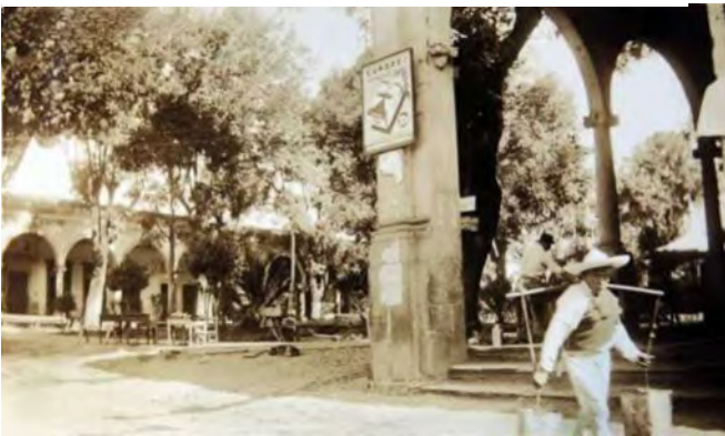
Fotografía 5 Vista desde fachada principal antes. Fuente: Archivo histórico Quiroga.
