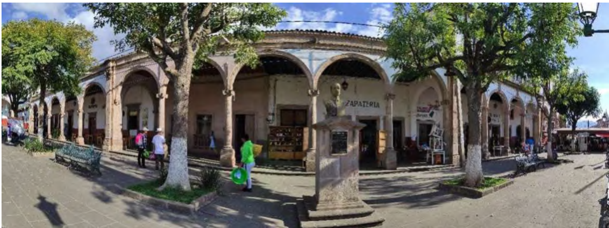
Fotografía 19 Foto panorámica fachada Portal Aldama. Foto: JMMF
