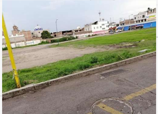
Imagen 46. Registro sanitario y alcantarillados calle revolución Fuente: Juan José García Martínez Fecha: Octubre del 2020
