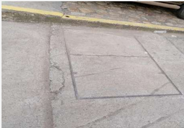
Imagen 47. Acometidas oopas calle 16 de septiembre Fuente: Juan José García Martínez Fecha: Octubre del 2020
