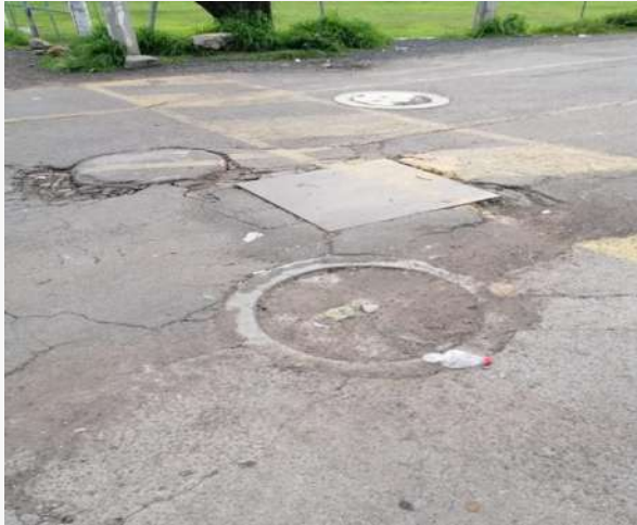
Imagen 45. Registros sanitarios y acometidas calle 16 de septiembre Fuente: Juan José García Martínez Fecha: Octubre del 2020
