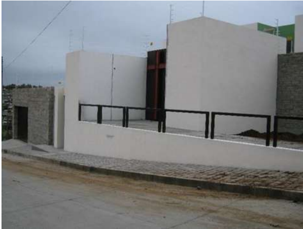
Imagen 49 Rampa de acceso propia NHD
