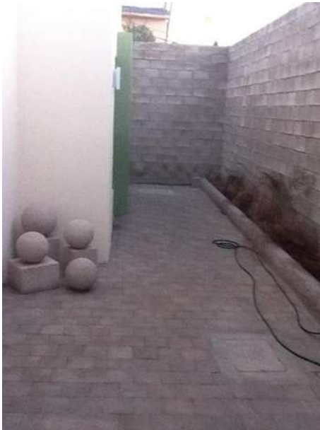
Imagen 52 Pasillo exterior AHD
