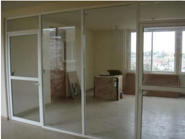
Imagen 66 Acceso a comedor y cocina NHD
