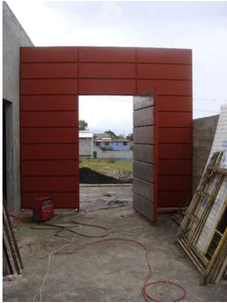
Imagen 47 Acceso principal (en proceso) propia NHD
