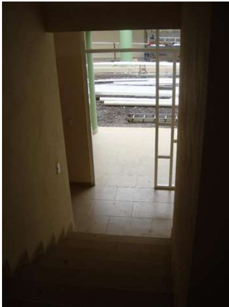
Imagen 54 Escalera de acceso a 2do nivel propia NHD
