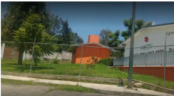
Figura 57 Módulo de sanitarios del ICATMI. Fuente: Google Maps
