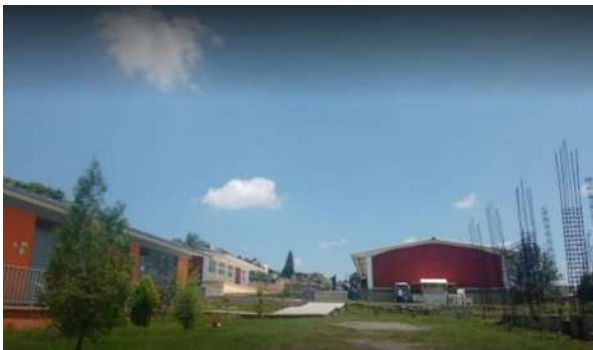
Figura 56 Vista de los talleres y parte de la construcción no finalizada. Fuente: Google Maps
