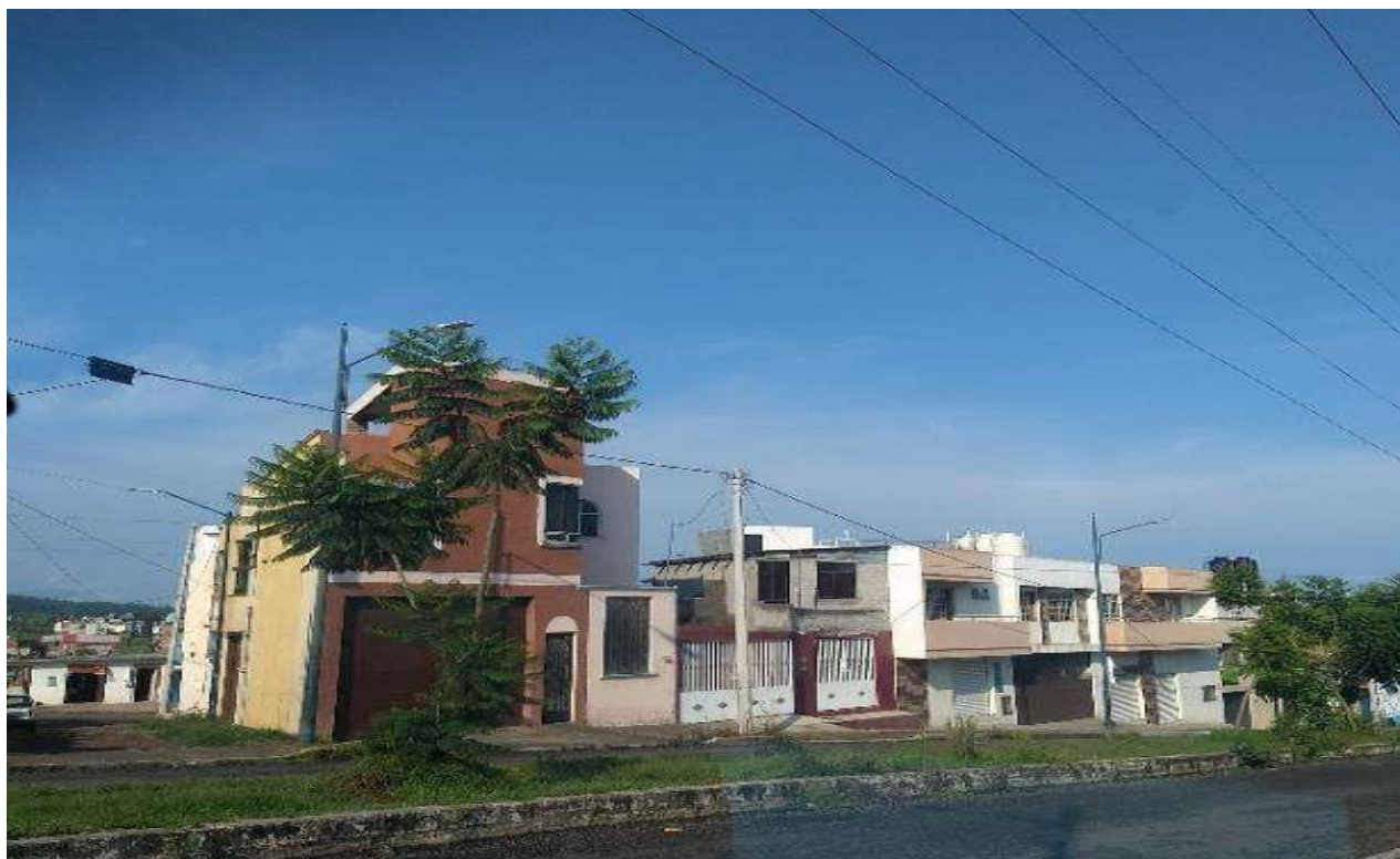
Figura 36 Vista 2 de casas de tabique y con acabados. Fuente: MICM
