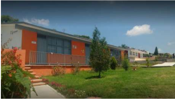
Figura 55 Vista de las aulas teóricas del ICATMI. Fuente: Google Maps
