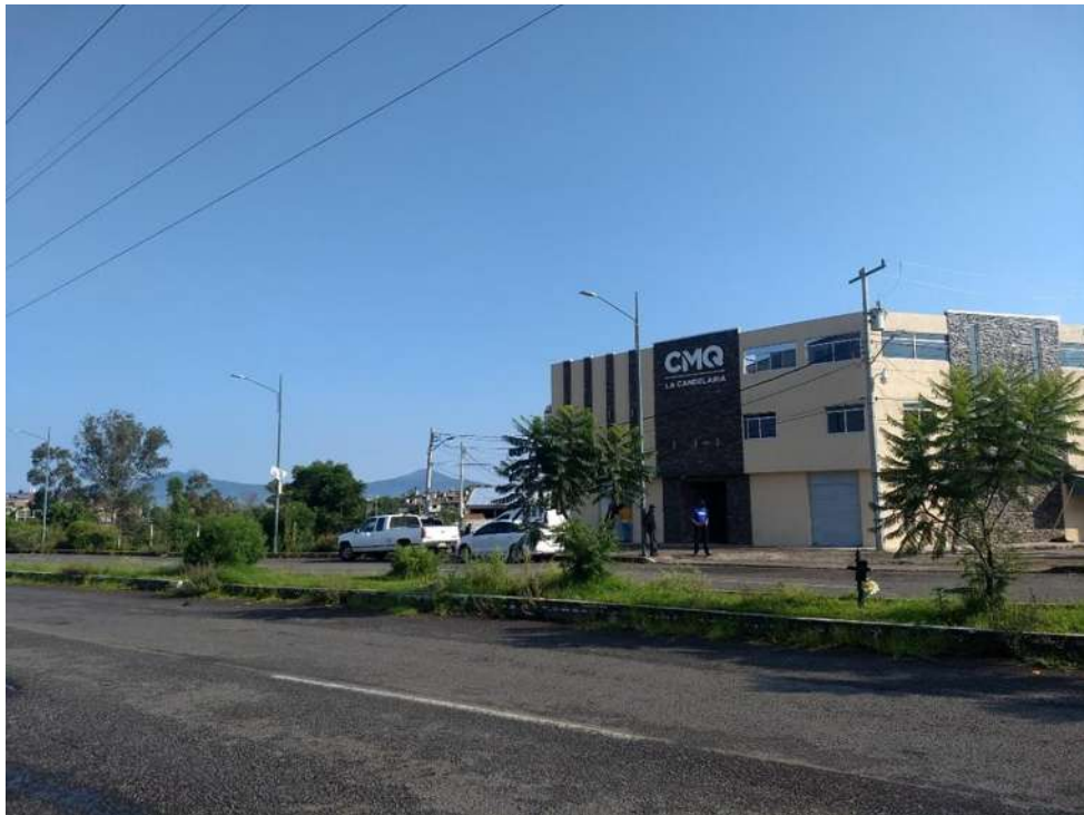
Figura 42 Vista 3 desde el terreno. Fuente: MICM
