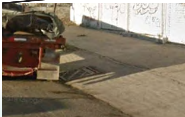
Ilustración 9 registro de inspección de alcantarillado sobre la cera FUENTE: GoogleEarth
