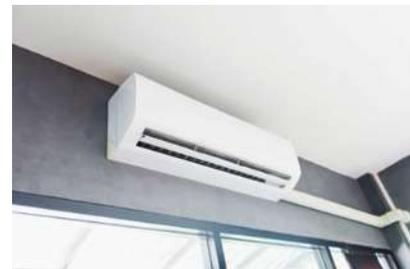
Imagen 5.16. Equipo de aire acondicionado tipo Split. Fuente: <https://friobensal.com/servicios/aire-acondicionado-tipo-split/>. [16/10/20].
