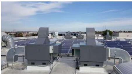
Imagen 5.15. Equipo de aire acondicionado tipo industrial. Fuente: <https://blog.resurtidora.mx/tecnologia-aire-acondicionado-industrial>. [16/10/20].
