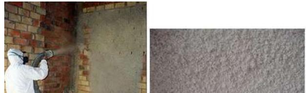
**Imagen 5.23.** Acabado térmico rustico de mortero de albañilería. Fuente: <https://www.grupounamacor.com/aislamiento-termico-tipos-y-recomendaciones/>. [16/10/20].
