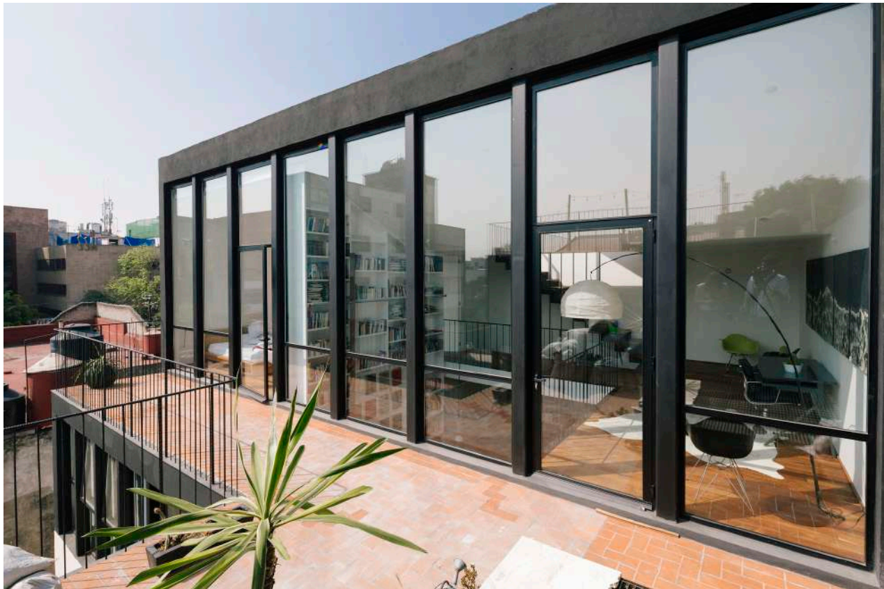
figura 85. vista desde terraza. Fotografía por Pedro Hiriart, Ciudad de México, 2012.
