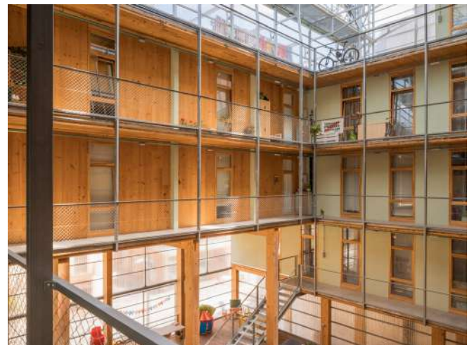
figura 69. vista desde el patio interior de La Borda. Fotografía por Lluç Miralles, Barcelona. 2018.
