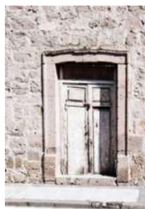
figura 111. estado de conservación de los accesos y ventanas en la fachada principal, se puede observar a la izquierda el acceso considerado a mantener, en la parte superior los que se reemplazarán debido a su estado de conservación (derecha) o porque no tienen relevancia histórica (izquierda), fotografías tomadas por el autor, 2020.
