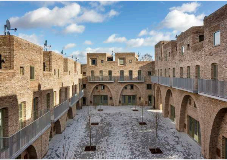
figura 11. vista desde patio al inmueble, fotografía por Peter Barber Architects, 2019.
