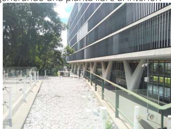
Figura 5. Detalle de columnas en "V"
