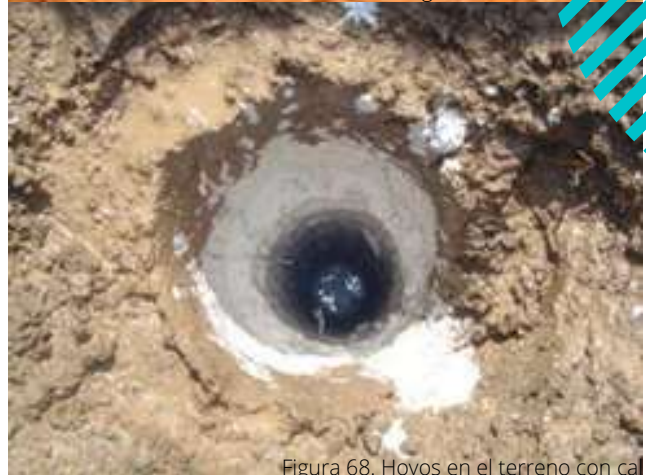
Figura 68. Hoyos en el terreno con cal
