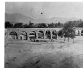
INICIO DE LA CONSTRUCCIÓN DEL ACUEDUCTO FUENTE: https://www.ecured.cu/Acueducto_de_Morelia#/media/File:Acueducto-de-moreliaAntes.jpg
