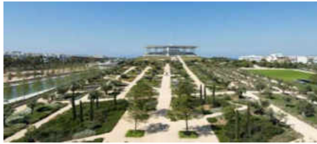
FIG 51. Centro Cultural stavros vista este Fuente: https://www.google.com/maps/place/Stavros+Niarchos+Foundation+Cultural+Cente
