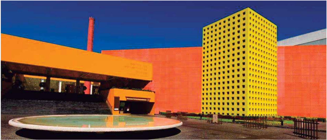
Figura 36. Acceso principal Centro de Convenciones William O. Jenkins. Obtenido de: https://transportamex.com/destinos/puebla/centro-de-convenciones/
