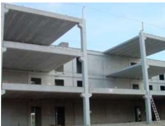
Imagen 59. Estructura de concreto armado. En: Tipos de materiales de construcción [FECHA: Octubre, 2021]
