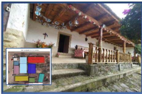
Fig. 24. Trojes de adobe con 65 centímetros de espesor de muros. Fotografía: María Elena Benito.
