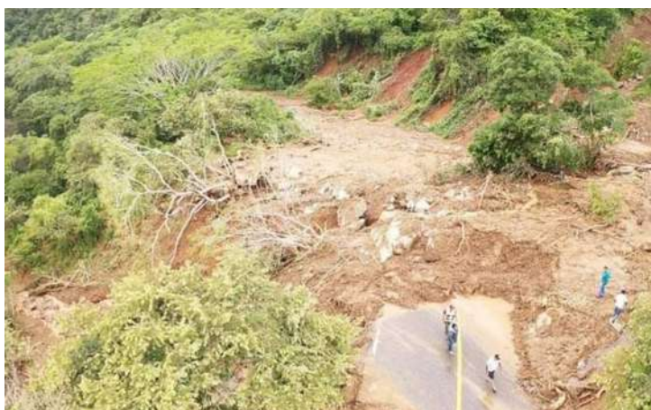
Imagen 06. Derrumbe en C. Calzada Benito Juárez, Arteaga, Mich. El sol de Morelia.
