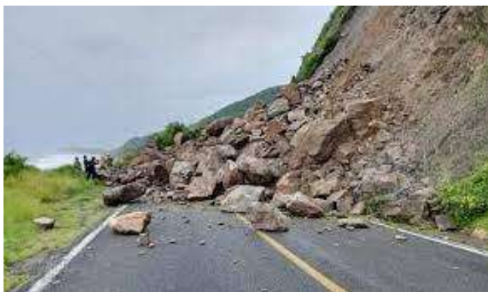
Imagen 05. Derrumbe en carretera Arteaga-Lázaro Cárdenas, Mich. El sol de Morelia.
